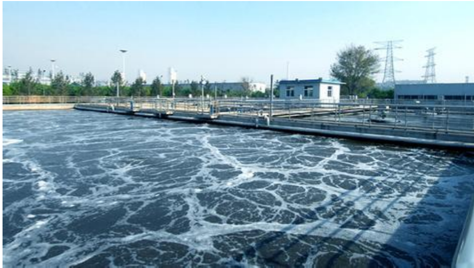
图55 南官市污水源清洁能源供热项目
